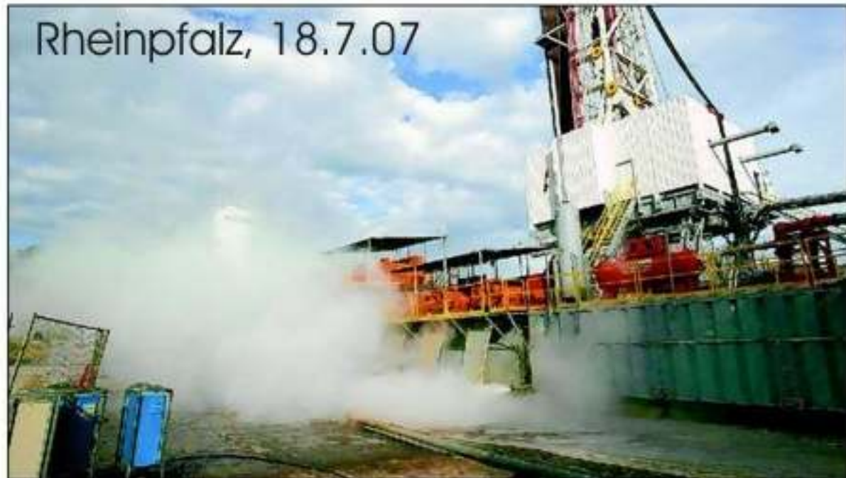
Da ist Dampf dahinter: In Landau waren Probebohrungen für ein Erdwärmekraftwerk erfolgreich.
